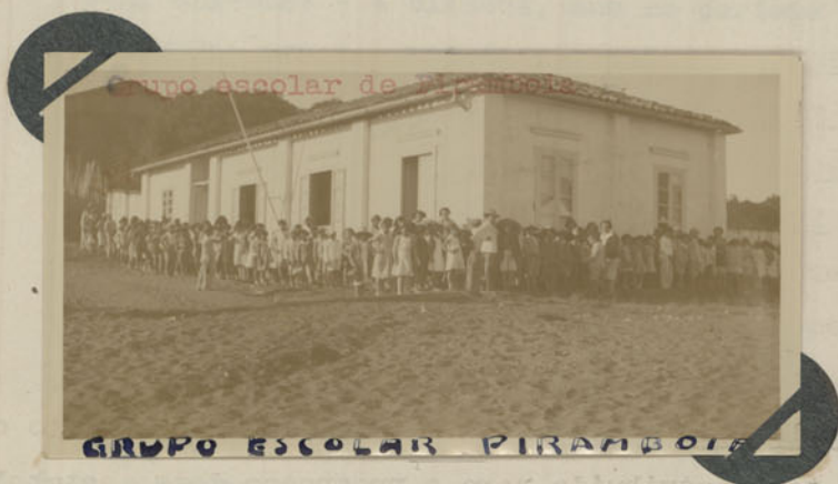
Prédio em que funciona o grupo escolar de Piramboia.
